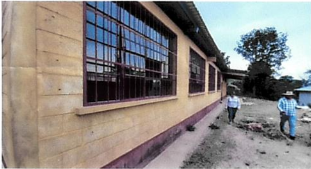
Foto 3: Cambio de ventanas a Tipo PVC
