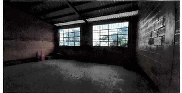
Foto 4: Sustitución de piso de granito por cerámico.
